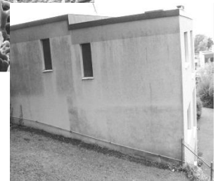
Oben: Fassadenpilz unter dem Mikroskop Rechts: Algen an einer Fassade
