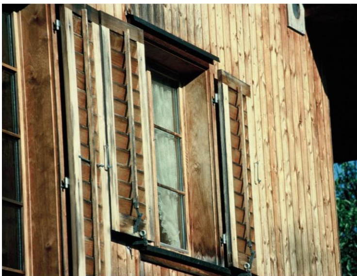
Legno tipicamente decolorato per effetto delle radiazioni UV.
