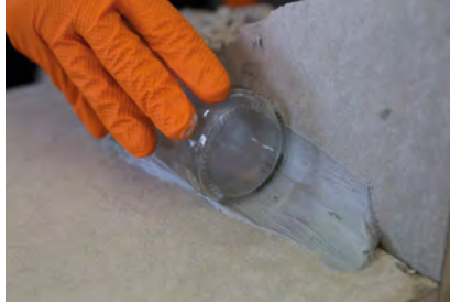
Bilden einer Hohlkehle
