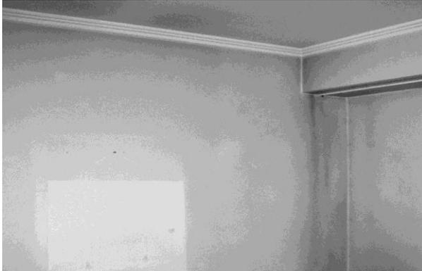
Unter Fogging-Effekt wird das plötzliche Vergrauen von Wänden, Decken und Einrichtungsgegenständen verstanden. Innerhalb weniger Tage oder Wochen bilden sich rissähnliche schwarze Ablagerungen. Die Schäden reichen von einzelnen Flecken bis zu grösseren verschmutzten Flächen, die aussehen, als hätte es in der Wohnung gebrannt.
